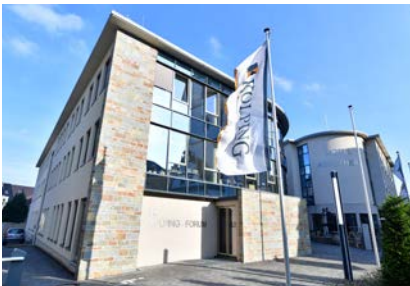
Hotel Aspethera, Paderborn www.hotel-aspethera.de
